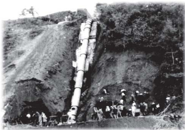
人力による発電所導水管の工事 1954（昭和29）年 森泉一成氏蔵
