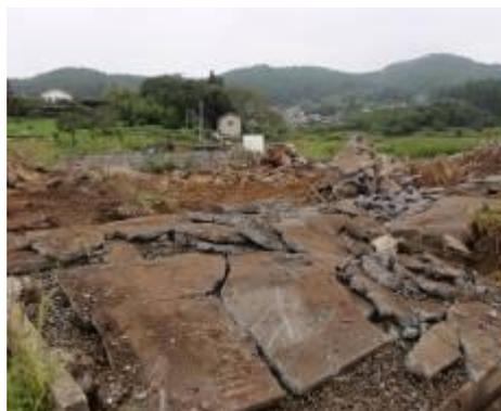
⑤ **コンクリート殻を捨て場に (仮置場) 運搬する** (3 t、4 t 10 t、11 t ダンプ使用)
