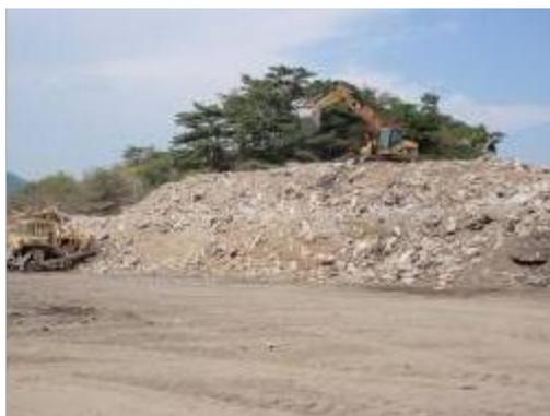
⑥ **整地及び便槽、浄化槽の撤去** (BH フォーク、バケット等使用)
