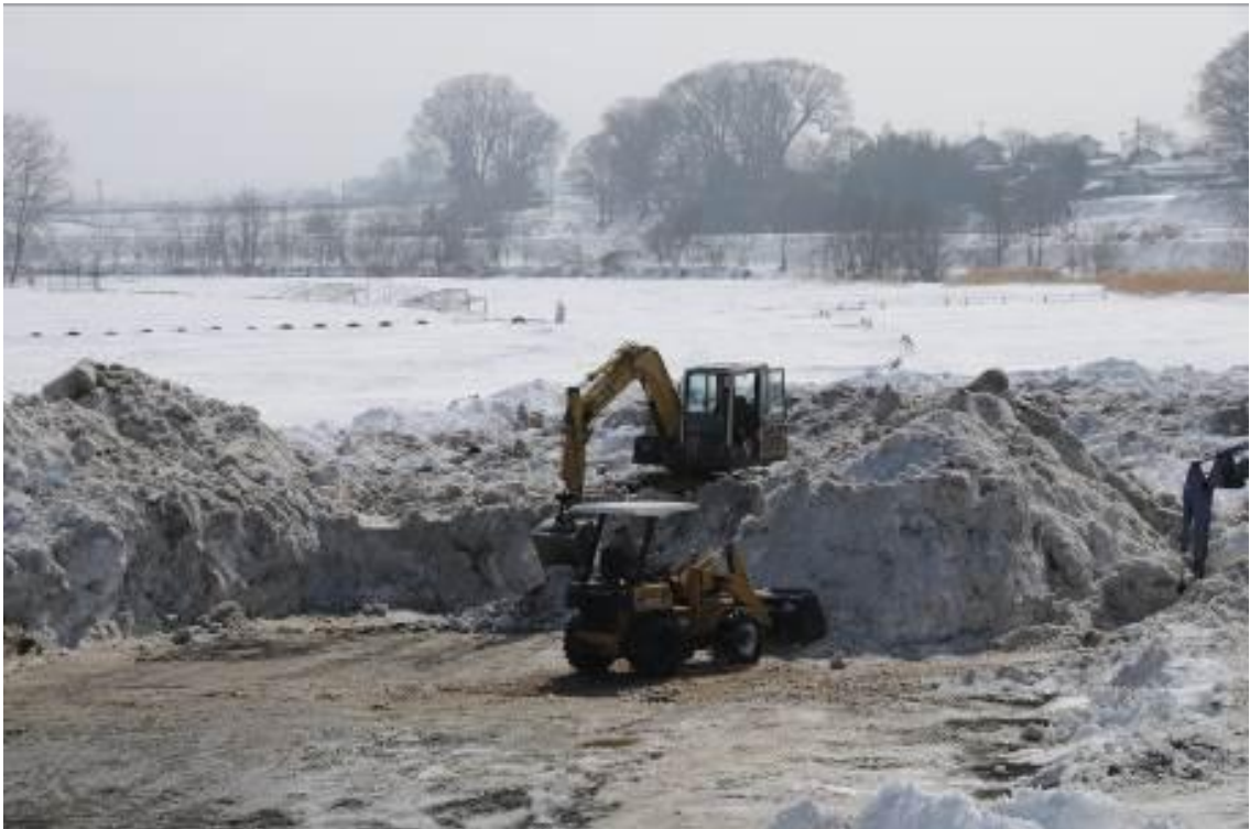
【写真：平成 26 年 2 月 26 日 雪捨て場（千曲川スポーツ交流広場）】
