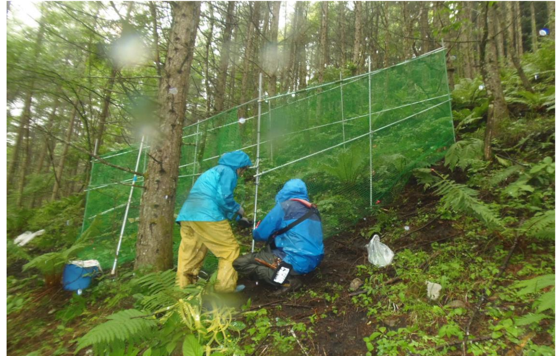
図4 植生回復柵設置風景
