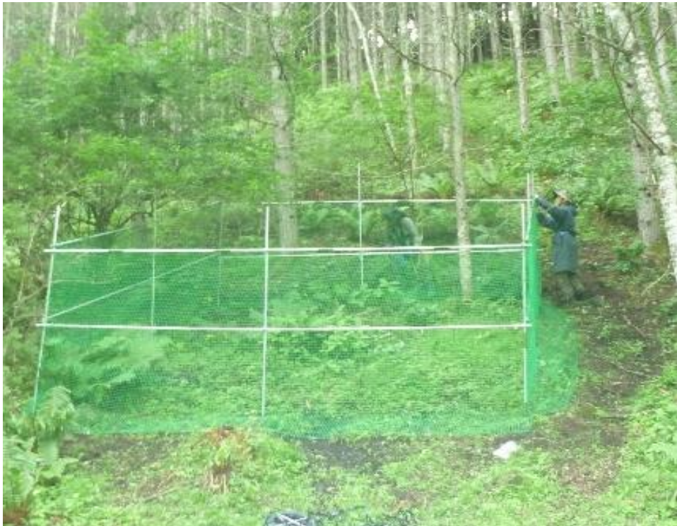
図3 植生回復柵設置風景
