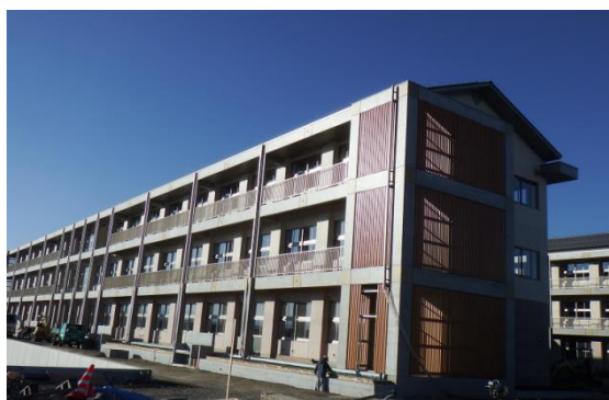
↑〔建設中の (仮称)佐久平浅間小学校〕
