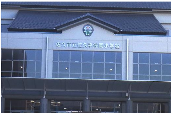
〔工事中の（仮称）佐久平浅間小学校〕
