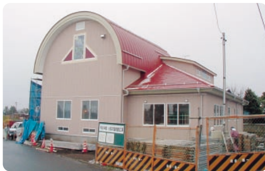
今年3月の開館に向けて工事が進む小田井児童館
