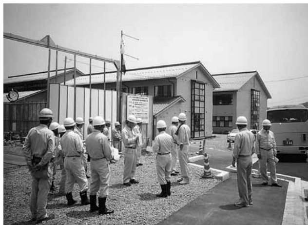
望月小学校（特別教室・屋内運動場等）建設工事現場にて
