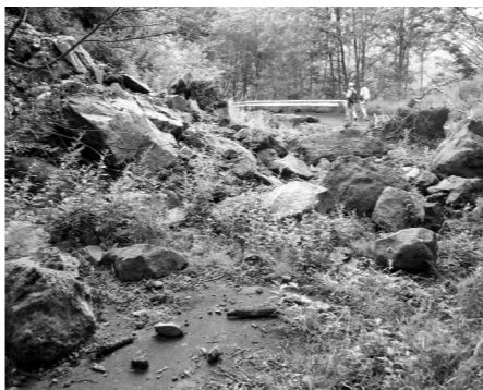
7年間全面通行止めの林道鹿曲川線
