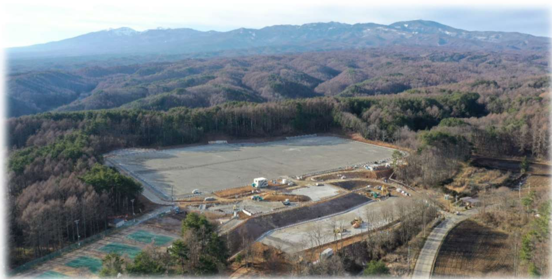
臼田総合運動公園（工事の状況）
