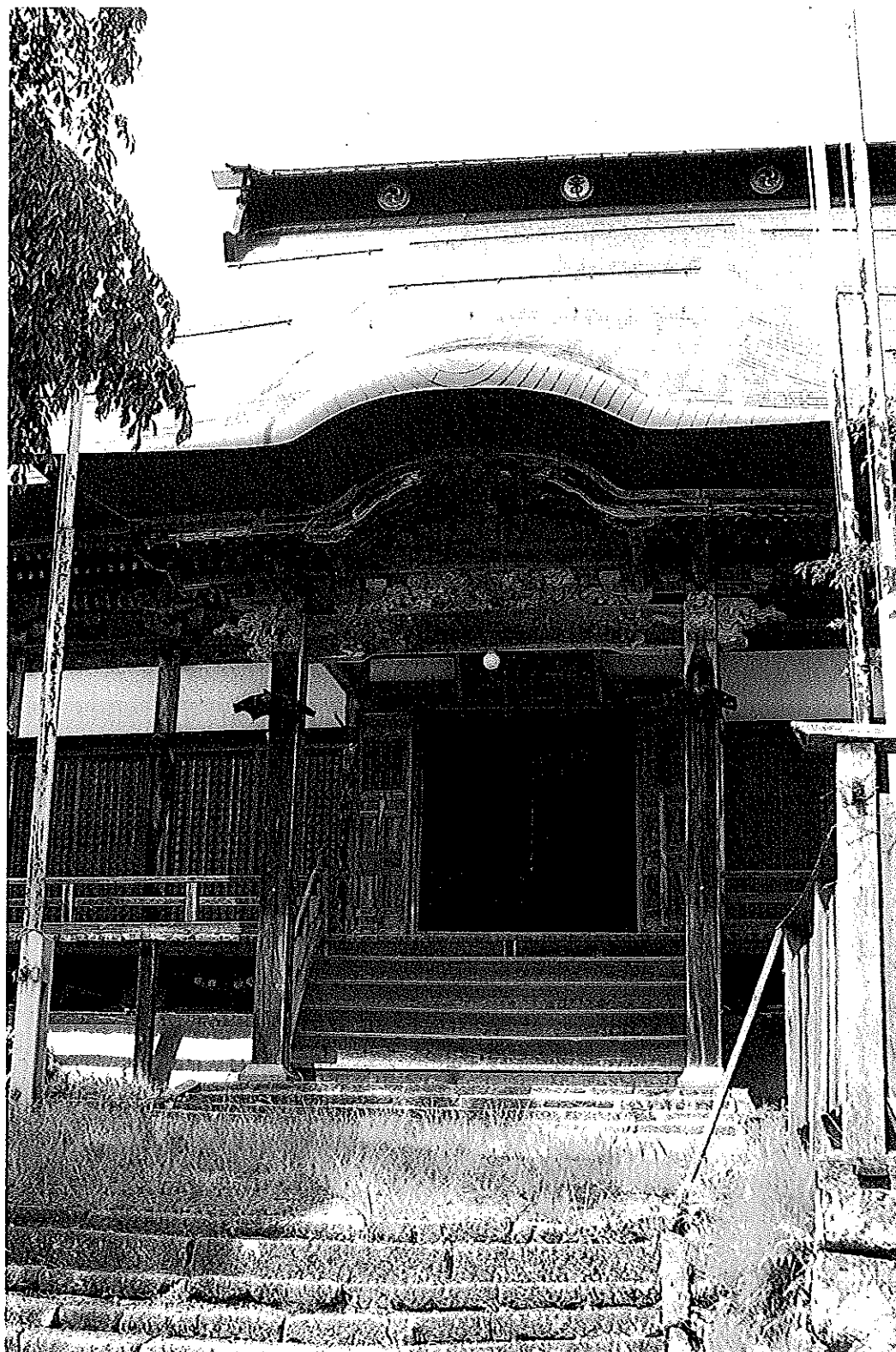
屋根の塗裝修繕
