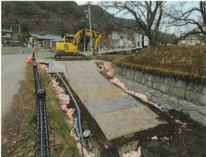
堀浚渫工事 工事車両等搬出路設置
