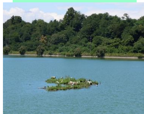
東京電力小諸発電所第一調整池
