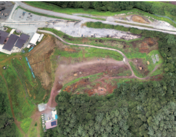
造成工事の始まった新クリーンセンター建設地
