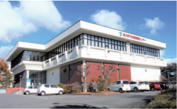
佐久市下水道管理センター
