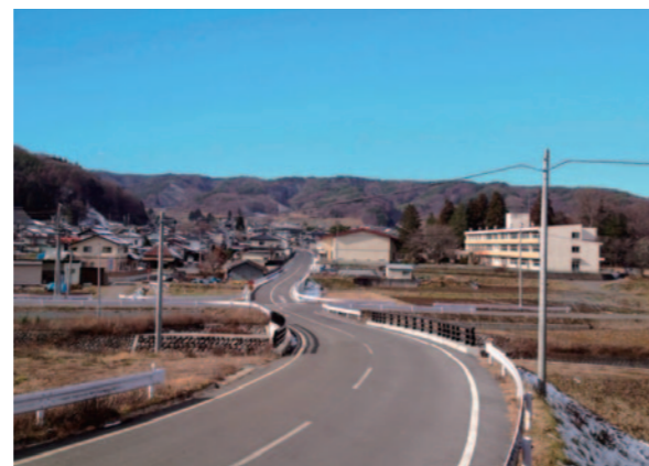
東西幹線第2期工区
