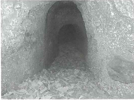
写真2 用水の堀貫（ ずいどう 隧道）
