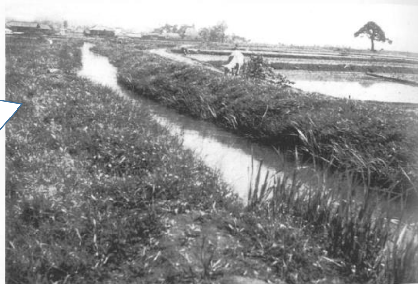
改修工事以前の五郎兵衛用水
