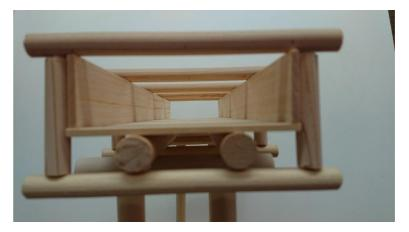
※ 河川法で規定する一級河川布施川を一気に渡りきるため、五郎兵衛は水道橋を布施川に架橋しています。常時大量の用水を流すため、橋には巨大な荷重がかかります。その重みを受けるため橋脚を増やすと、布施川本流の流下に悪い影響を及ぼすため、巨木の一木を用いて橋自体に強度を持たせました。
