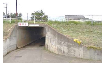
中原R142アンダーパス
