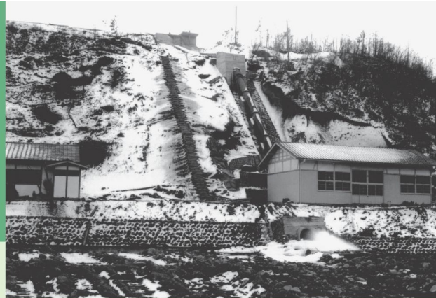
完成直後の発電所
