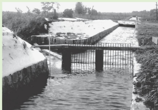
発電所導水路と平尾用水の分水点
