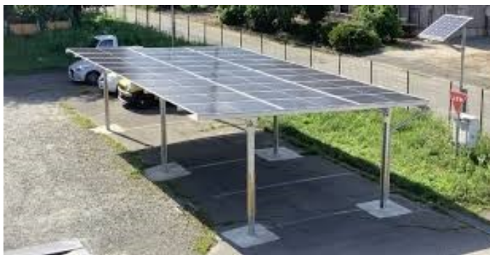
図 3-5 ソーラーカーポートや野立て（積雪深考慮）での設置方法例（外観例と設計図例）（設置方法 5）
