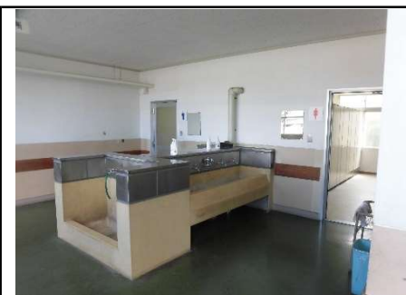
27 北校舎棟 1階トイレ
