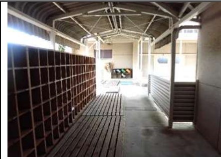
51 屋内運動場への渡り廊下
