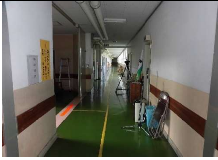
19 中校舎棟 1階廊下
