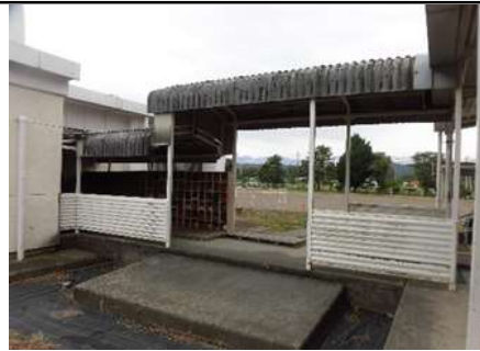
52 屋内運動場への渡り廊下
