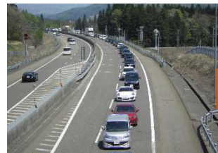
4車線化前(坂田新田橋)
