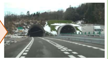
4車線化後(観音平トンネル)
