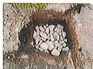
浸透確認後、50cm埋戻し
