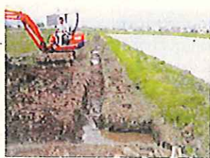
排水路と浸透枿の接続
