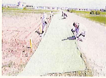
シート設置中
