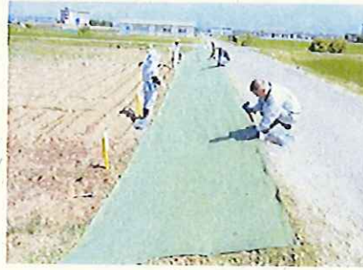
シート設置中
