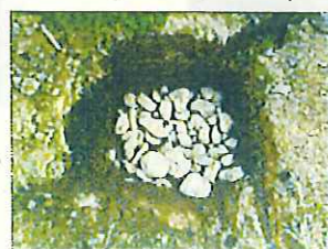
浸透確認後、50cm埋戻し
