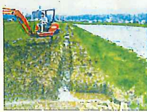
排水路と浸透柵の接続
