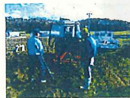
掘り上げ機での作業
