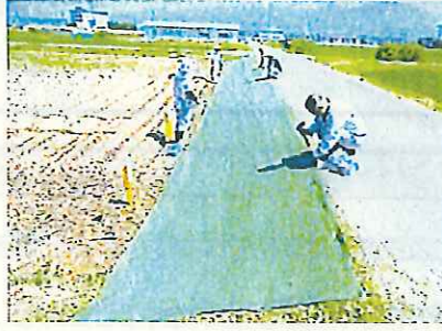
シート設置中
