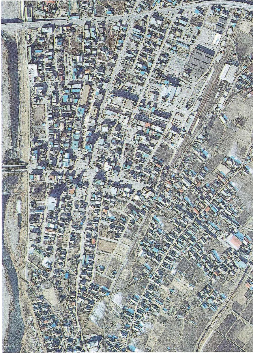
完成写真（S 62年12月撮影）
