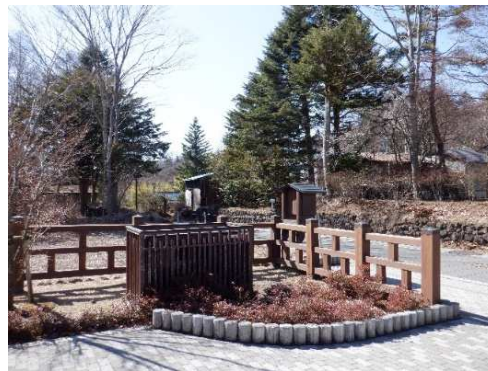
写真 公共用地等への地上機器設置例 （長野県軽井沢町）
