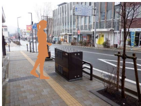
写真 地上機器の大きさの対比 （長野県小諸市）
