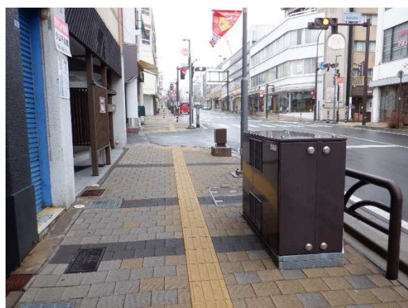
写真 歩道上の地上機器 (長野県小諸市)
