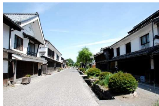
図 裏配線の事例 (長野県東御市・海野宿)
