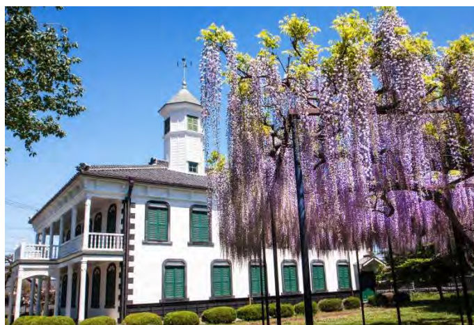
旧中込学校舎（国指定 重要文化財）
