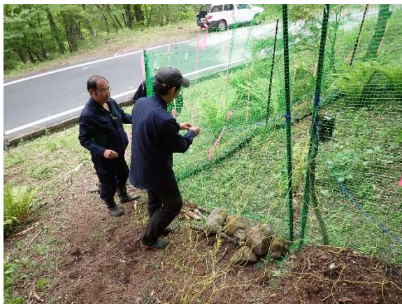
植生回復柵設置状況
