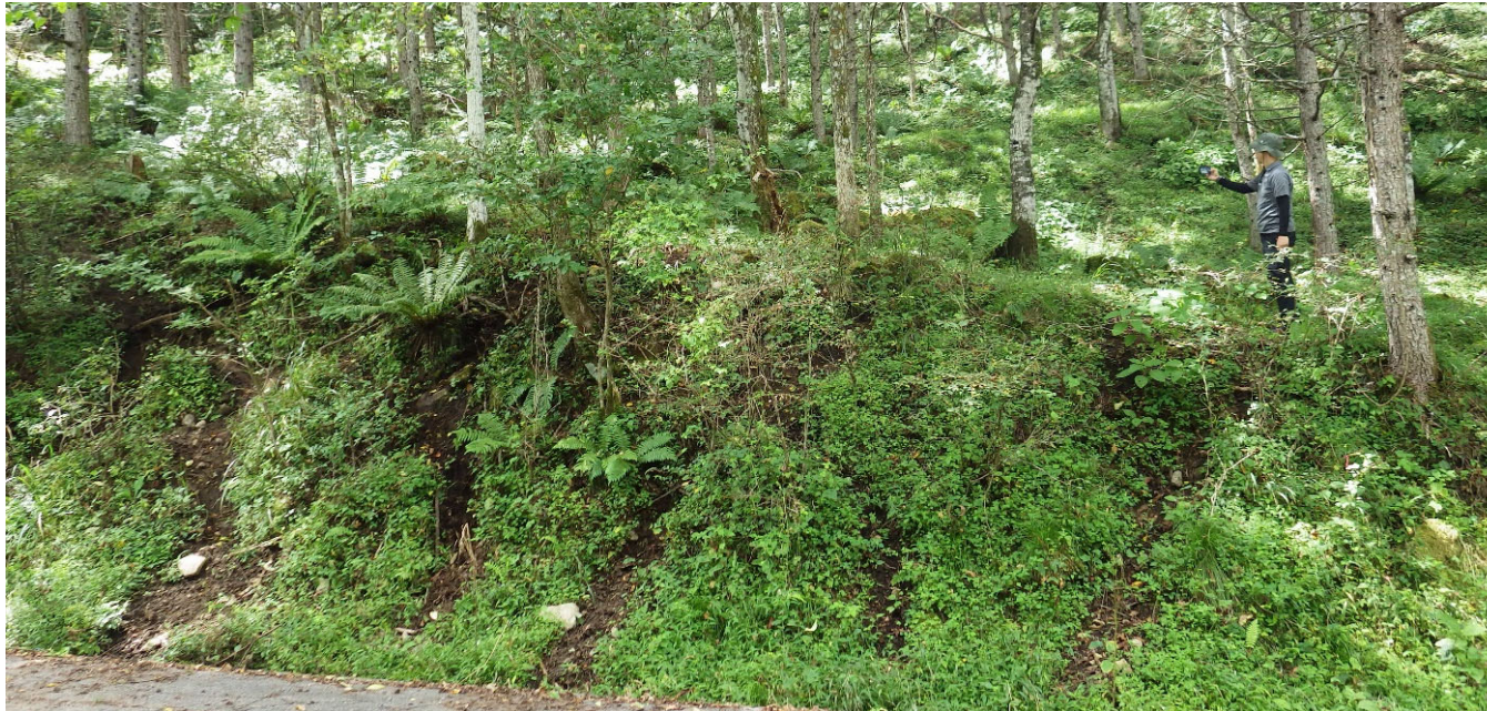
土壌侵食の様子
