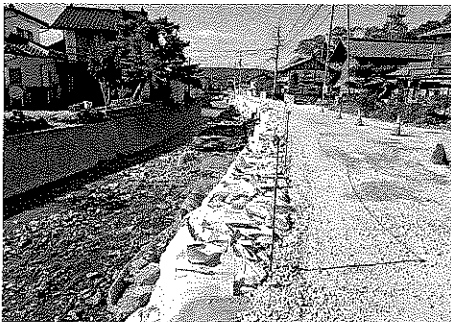
仮復旧された谷川沿い
