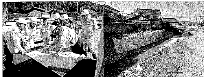
谷川の被災状況を確認 (入澤区)
