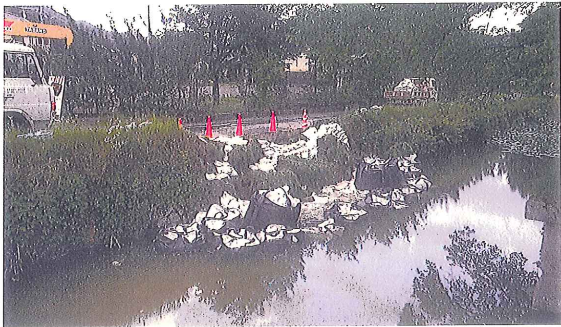
国史跡龍岡城跡 応急工事状況（通常土嚢設置完了状況、石垣上部の崩落した版築土の固定と雨水対策）
