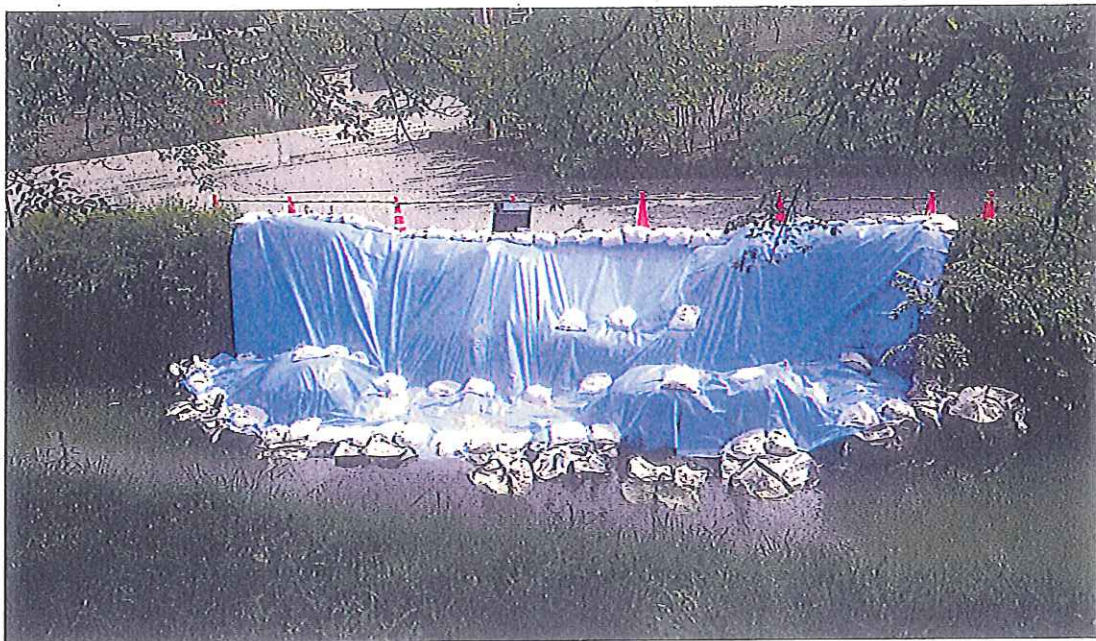
国史跡龍岡城跡 応急工事完了状況（雨水浸入を防ぐための養生シートの設置と固定）
