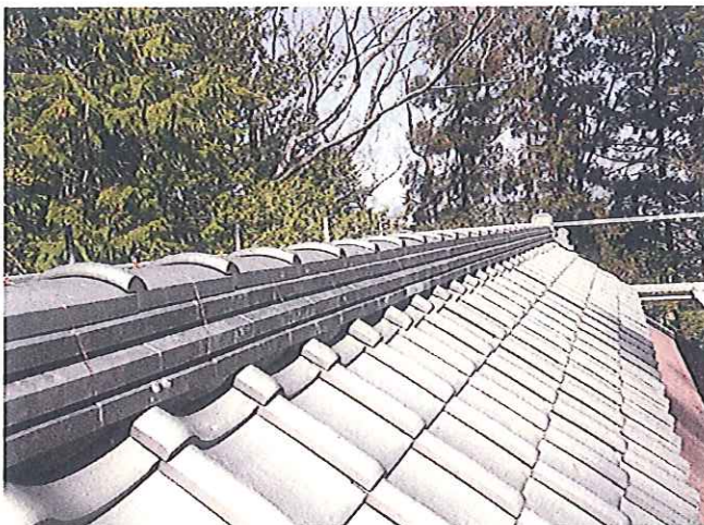
○島崎藤村旧宅 指 定:なし 所在地:佐久市前山 所有者:佐久市 屋根峰部分の傷みが激しいことから、棟瓦・軒瓦の交換・修繕及び野地板の交換を実施した。 平成26年度は、4月19日から11月3日まで開館(月曜日・木曜日休館、祝日の場合はその翌日)
