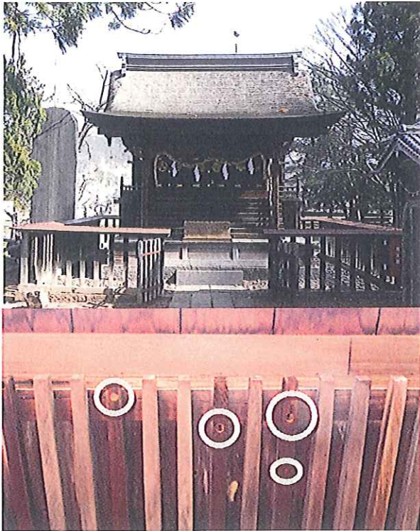
○高良社(旧八幡神社本殿) 指 定:国重要文化財(昭和17年12月22日) 所在地:佐久市蓬田 所有者:八幡神社 八幡区により、軒下部分への薬剤の塗布による防虫処理が実施され、佐久市文化財保護事業補助金を交付した。
