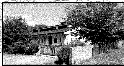
松原地区農業集落排水処理施設
