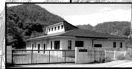
八那池地区農業集落排水処理施設
