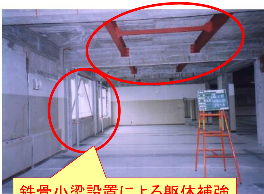
【工事中 躯体補強】
