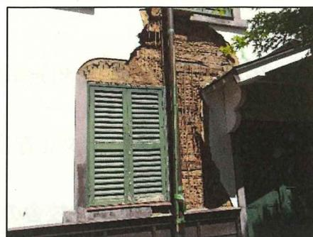
上の写真は被害が一番大きい外壁の崩落部分です。現在足場が設置してある3面について多くの亀裂が発生し、漆喰に浮きが生じている状況です。
