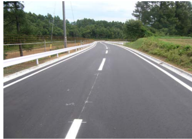
②完成状況
