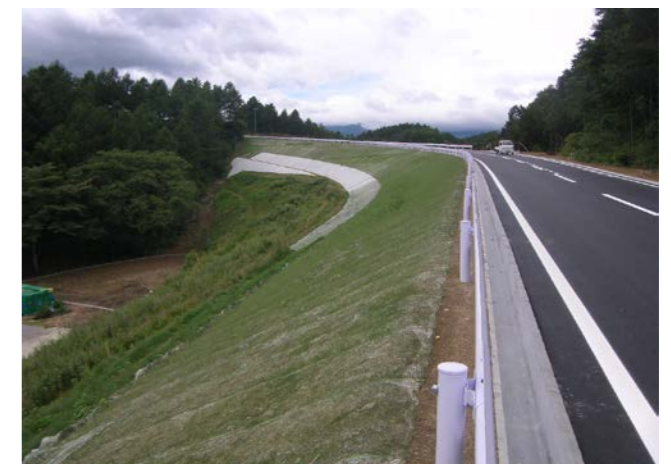
④完成状況
