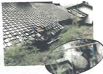
今年のお盆の大雨後 土砂災害特別警戒区域 内で落石があり、 家屋が損壊しました。
