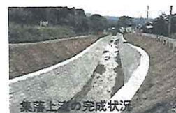
集落上流の完成状況
