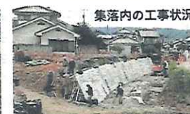
集落内の工事状況
