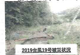
2019台風19号被災状況
