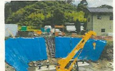
常和4号橋（仮称）の工事は8月中旬に右岸左岸ともに7本ずつの杭の施工が完了し、橋台・橋桁の設置に入ります。
