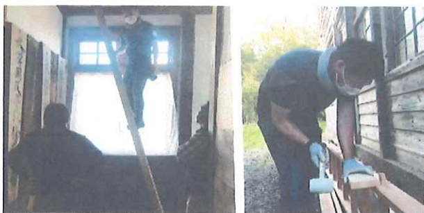
屋根裏見学梯子
