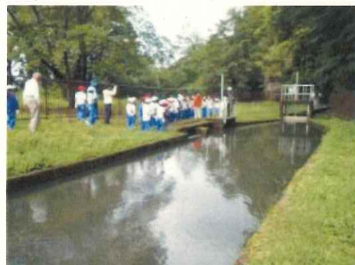
▲沈砂池(頭首工の直下流部にある。地元 の小学生が水路の勉強をしている)
