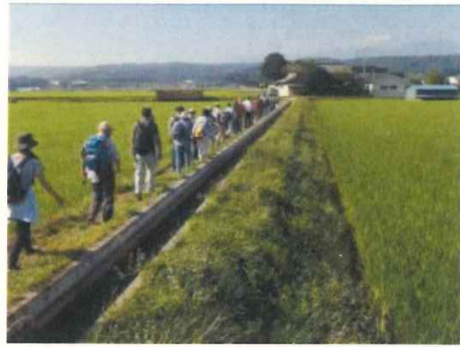
▲築堰（高盛土をして用水を送っている）
