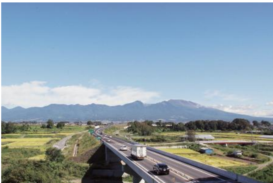
中部横断自動車道
